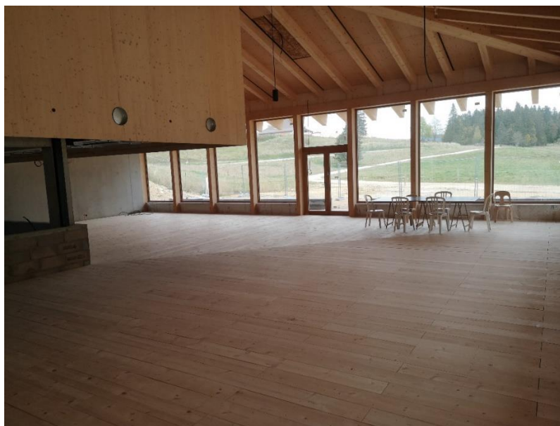
Figure 1. Salle du restaurant du bâtiment d'accueil
