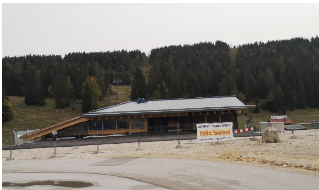
Figure 2. Bâtiment hors d'eau et hors d'air, inachevé
